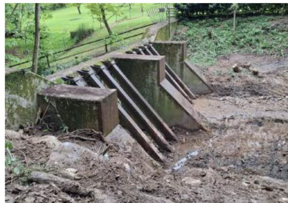
Dadurch konnten Sedimente, Material und Verkläuerungen von Bächen ausgehoben werden. Rückhaltebecken dienen der vorübergehenden Speicherung von Niederschlagswasser, um Abflussspitzen zu dämpfen. Einerseits können sie die Kanalisation und die Gewässer vor Überlastung schützen und andererseits das Gemeindegebiet vor Überschwemmungen sichern.
