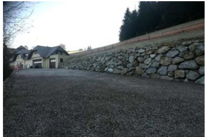
Parkplatz beim Rüsthaus Heilbrunn
