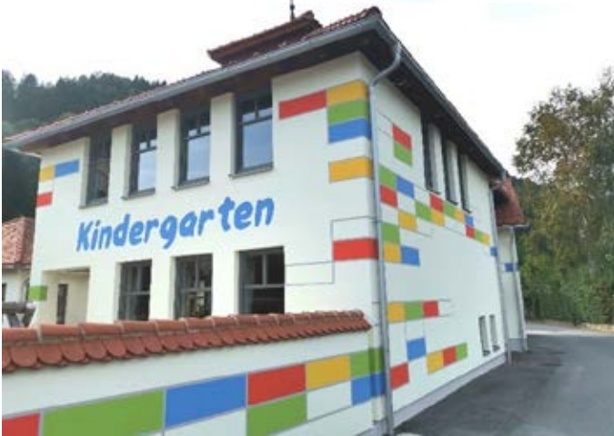
Sanierung Kindergarten Anger
